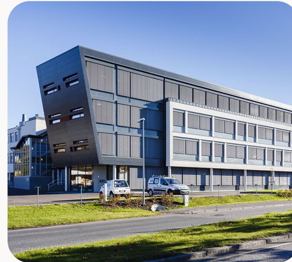
Kjelleveien 21 (Vinkelbygget), Tønsberg
